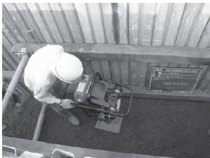
下水道管布設工事（埋戻し）
