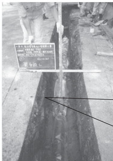
水道管路の布設替（耐震化）工事
