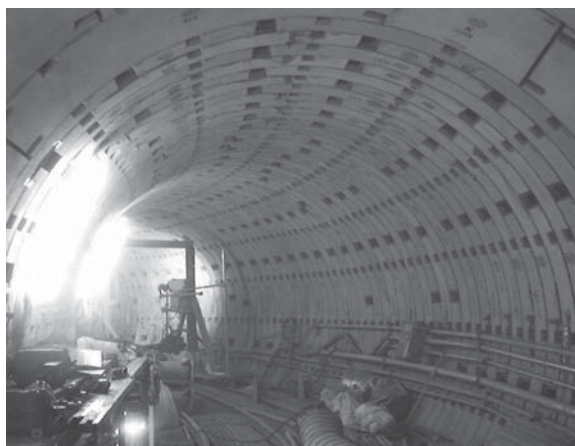
雨水貯留幹線の整備工事 (有栖川中央幹線(雨水) (その1) 公共下水道工事)
